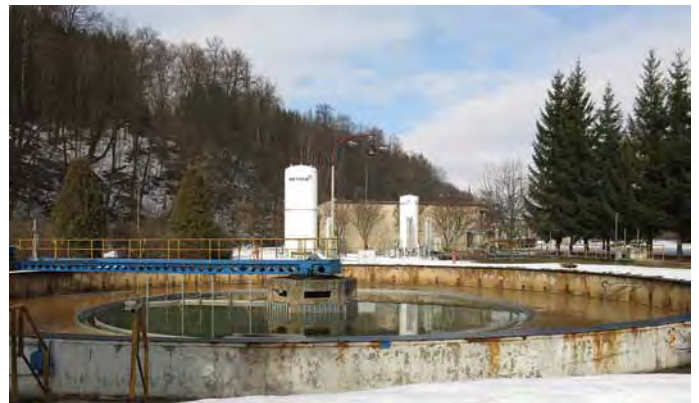
Obr. 2. Aktivační a dosazovací nádrže. V pozadí je zásobník kapalného kyslíku (vlevo) a zásobník kapalného oxidu uhličitýho (vpravo).
