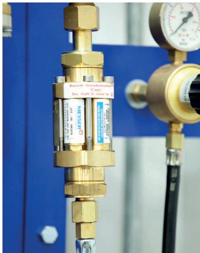
Obr. 6 – Pojistka proti zpětnému šlehnutí
