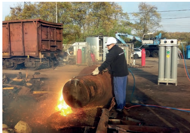
Obr. 1 – Dělení materiálu kyslíkem
