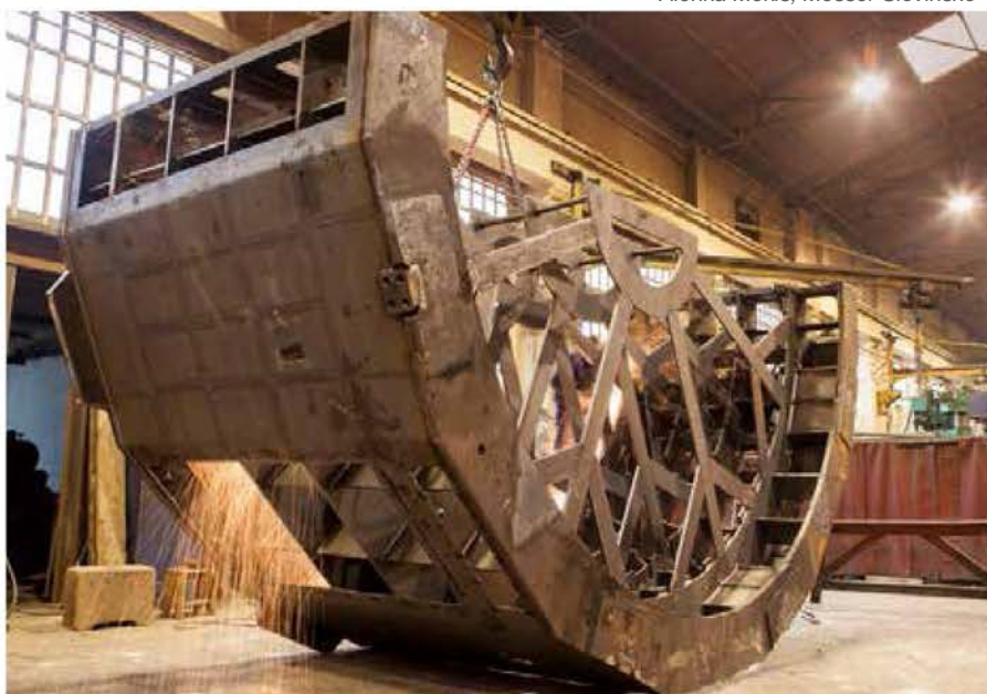
Súčasť rámu generátora s päťmetrovým priemerom pre hydroelektrickú napájaciu stanicu.
