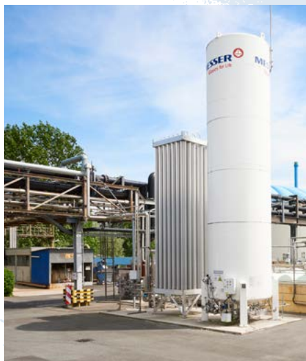
Instalace zásobníku u zákazníka
