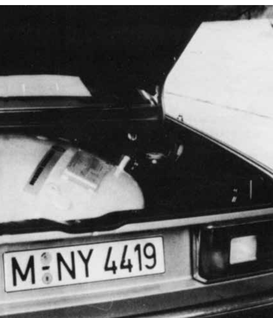
Das Versuchsfahrzeug, ein BMW 735i, läuft mit 130 Liter Wasserstoff-flüssig als Treibstoff im superisolierten Tank mehr als 400 km weit.
