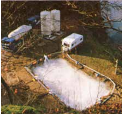
Gefrieren von Erdreich legt Baustelle trocken
