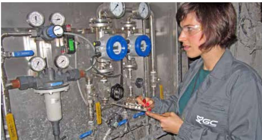
Eine Mitarbeiterin von Gomà-Camps notiert Anzeigenwerte der CO<sub>2</sub>-Kontrolleinrichtung.
